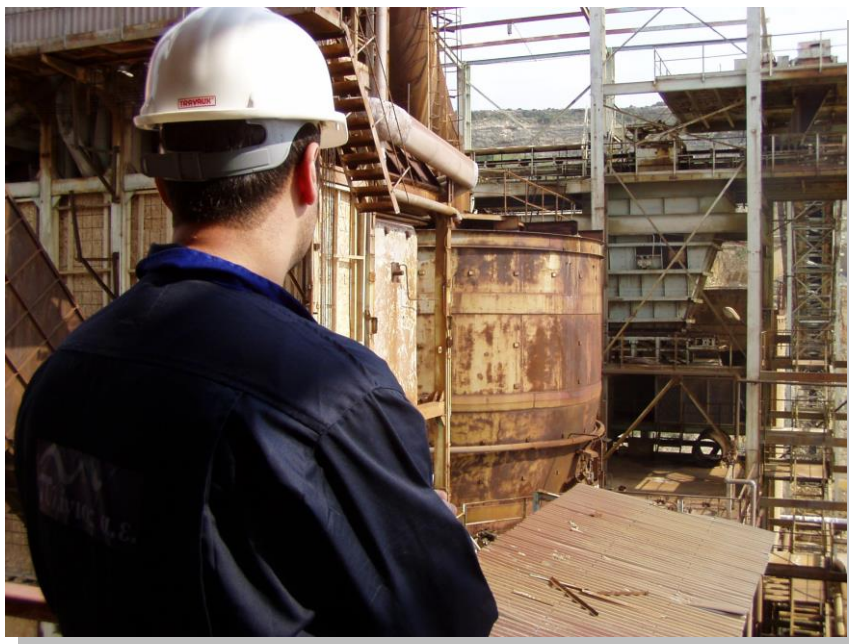
Έλεγχος ρύπανσης αμιάντου κατά τη διάρκεια κατεδάφισης των εγκαταστάσεων των ΕΛΛΗΝΙΚΩΝ ΧΗΜΙΚΩΝ ΒΙΟΜΗΧΑΝΙΩΝ, ΚΥΠΡΟΣ
